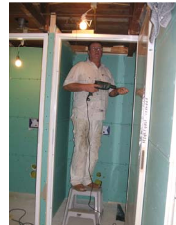
Henny Verveer aan het werk in het dames toilet
